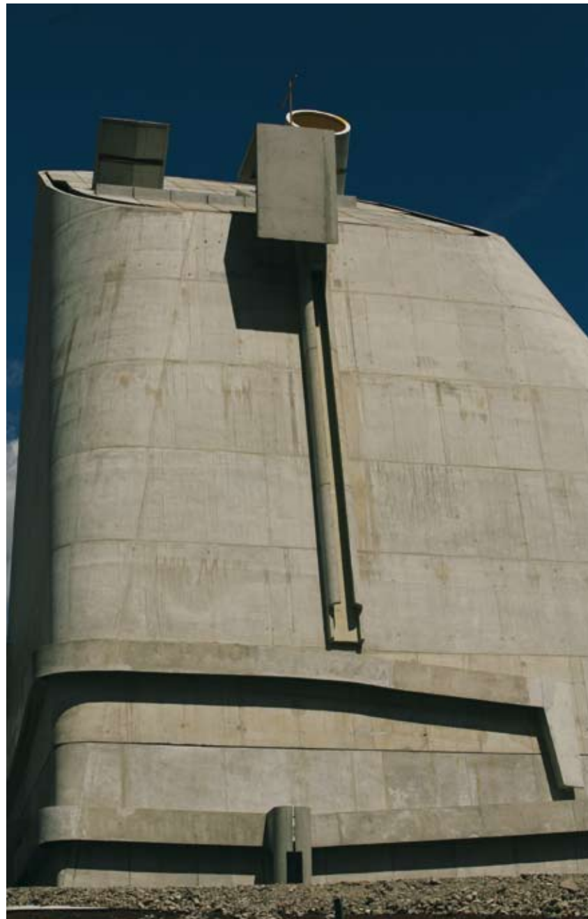
Le chemin de l'eau se dessine en relief sur la peau de béton.
