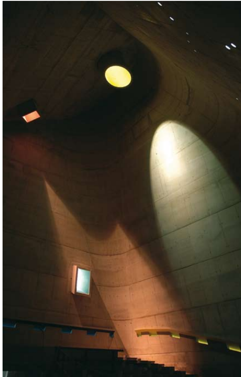
Les canons à lumière modifient le volume intérieur.
